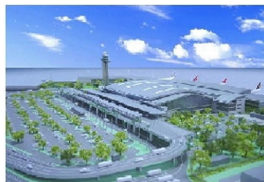
Công trình mở rộng nhà ga sân bay Tân Sơn Nhất
